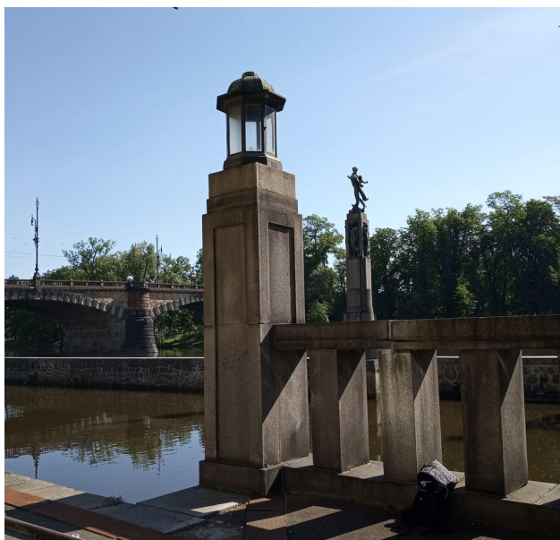
Foto č.6 – kamenné zábradlí, k přezdění
