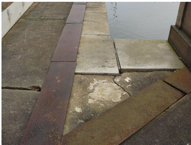
Foto č.5 – korunní kameny (budou přezděny), stávající vedení sítí v krytém kanálu
